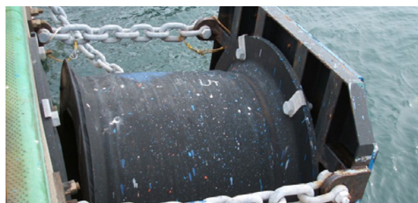
Adherencia insuficiente
