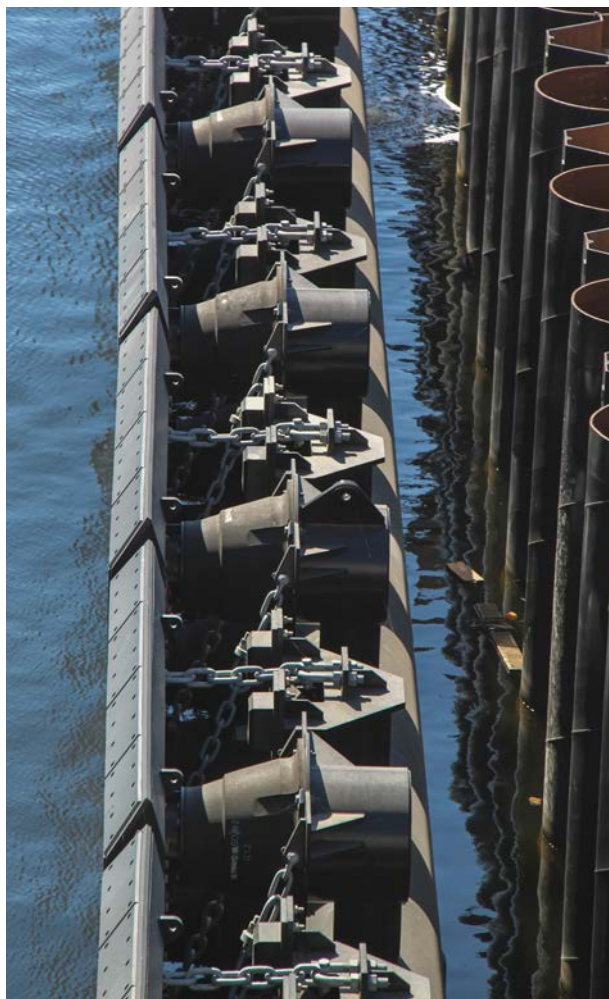
Odbojnice stożkowe (SPC) | IJmuiden | Holandia
