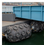
Défenses pneumatiques avec filet de chaîne et de pneus Terminal de croisière Rostock, Allemagne (2016)
