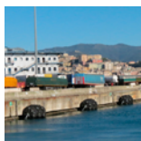
Défenses pneumatiques avec filet de chaîne et de pneus Terminal de Ferry Ponto Colombo T7 Gênes, Italie (2016)
